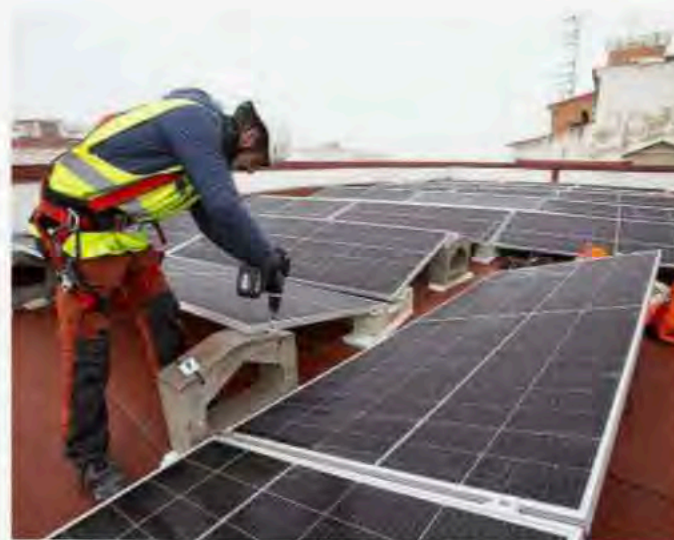
Instalación de placas solares en la azotea de un edificio comunitario. / O. NAVARRO
